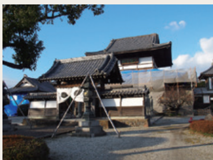
▶熊本県大慈寺様。地震による被害を受け修復作業中。
